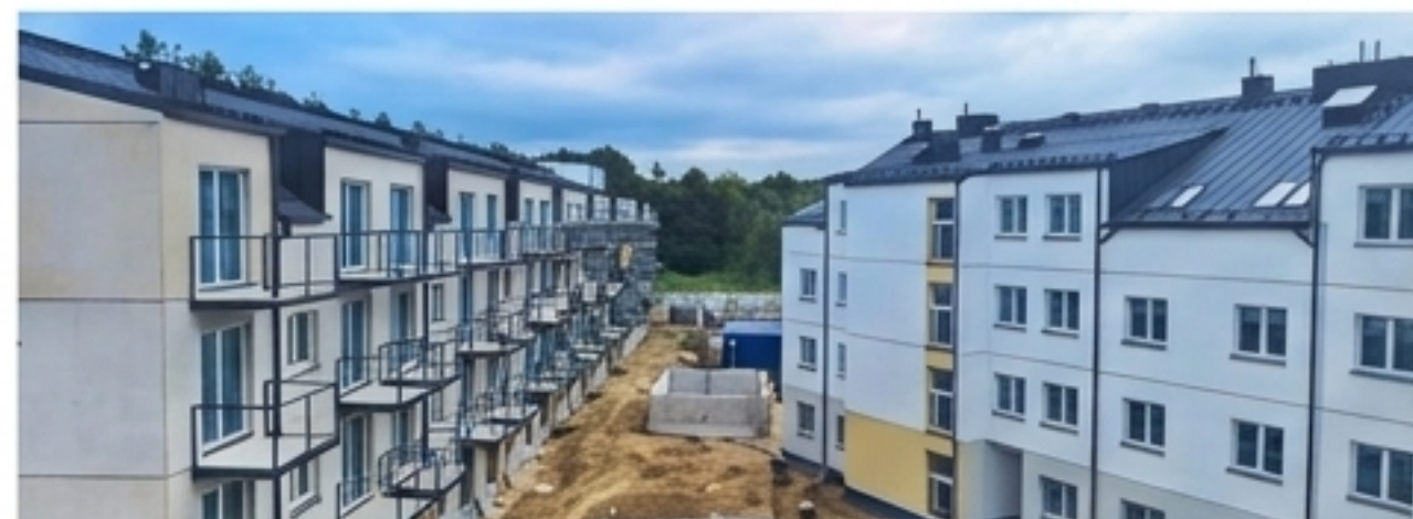
Gdańsk (ul. Pastelowa) - Budowa Zakończona (319 mieszkań).
