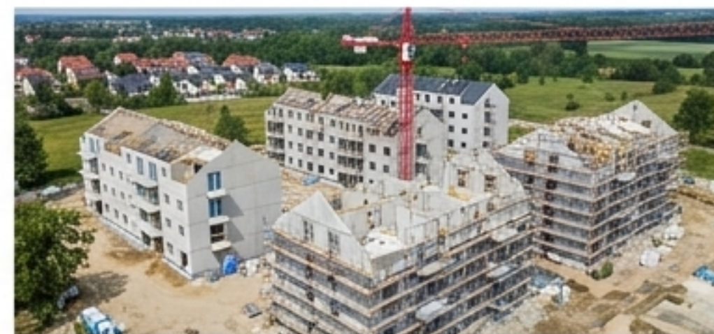
Leszno (Osiedle Grono) - W trakcie budowy.
